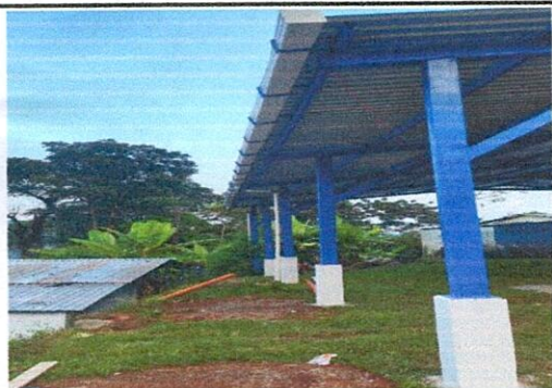
Foto 5: canales y bajadas pluviales
