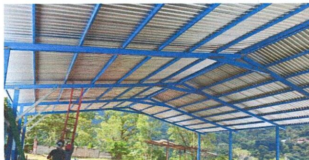
Foto 2: Cubierta de lamina troquelada C.16
