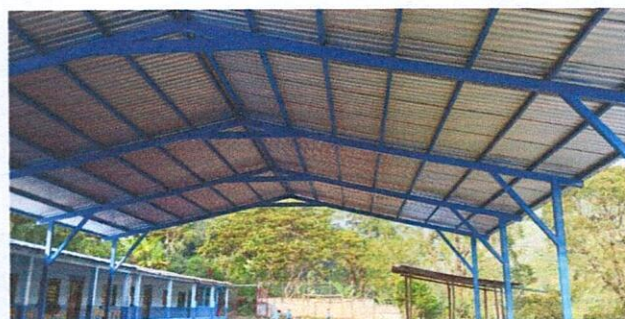
Foto 6: Mejoramiento de estructura portante
