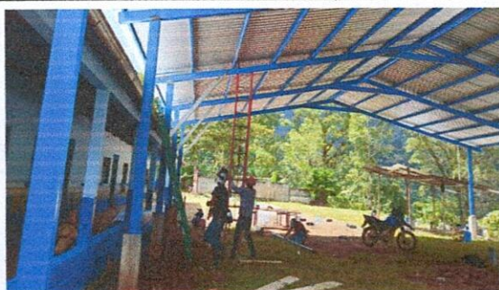
Foto 4: Estructura de techo tipo portico
