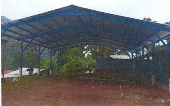
Foto 3: Estructura de techo tipo portico
