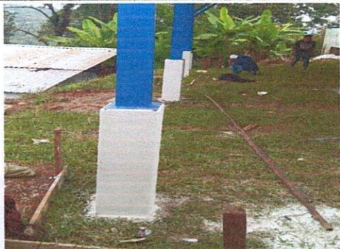
Foto1: Mejoramiento de estructura portante
